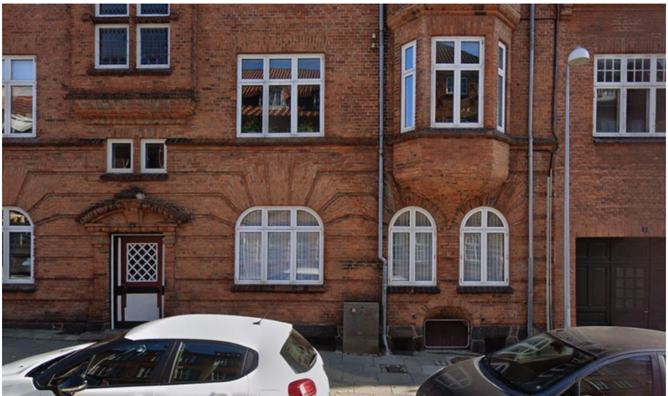
Mønstermurværk ved eksisterende bygning på Dumpen 4.
