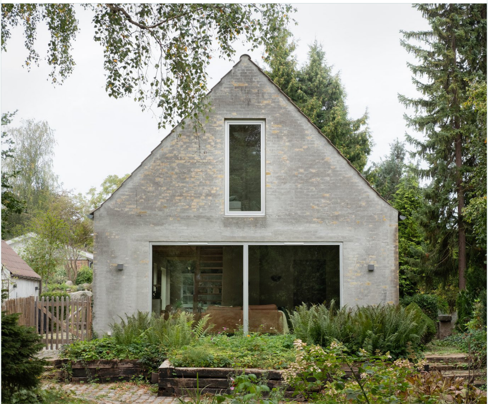
Enfamiliehus, Bagsværd / Dyrendahl / 2024 / Foto: Lovisa Nordlöf. I transformationen af dette hus fra 1979, har man intergreret nogle generøse vinduer uden brystning, som skaber et åbent kig på tværs af huset og en visuel kontakt til haven.
