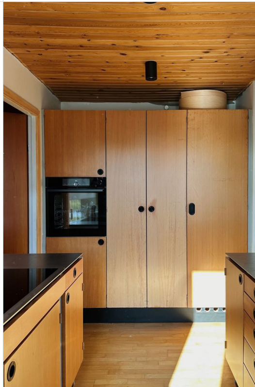
Renovation af parcelhus, 1968 / Anne Birkkjær / 2024. Foto: Anne Birkkjær. Hos Anne Birkkjær er køkkenet nænsomt renoveret med få greb: lågerne er slebet, og bordpladen udskiftet.
