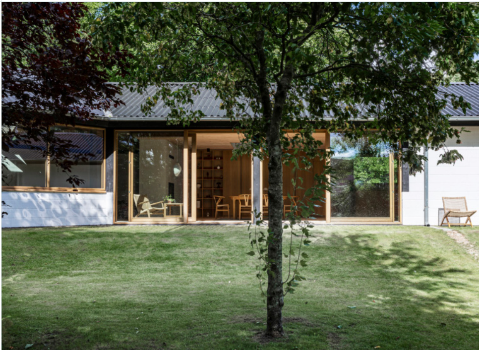
Ombygning og istandsættelse af villa fra 70'erne / tegnestuenlorenzen / Foto: tegnestuenlorenzen. I mødet mellem villaens eksisterende opbygning i gasbeton og tilføjelsen af nye egetræselementer, får huset nu sin hel egen karakter, samtidig med at husets ånd består.
