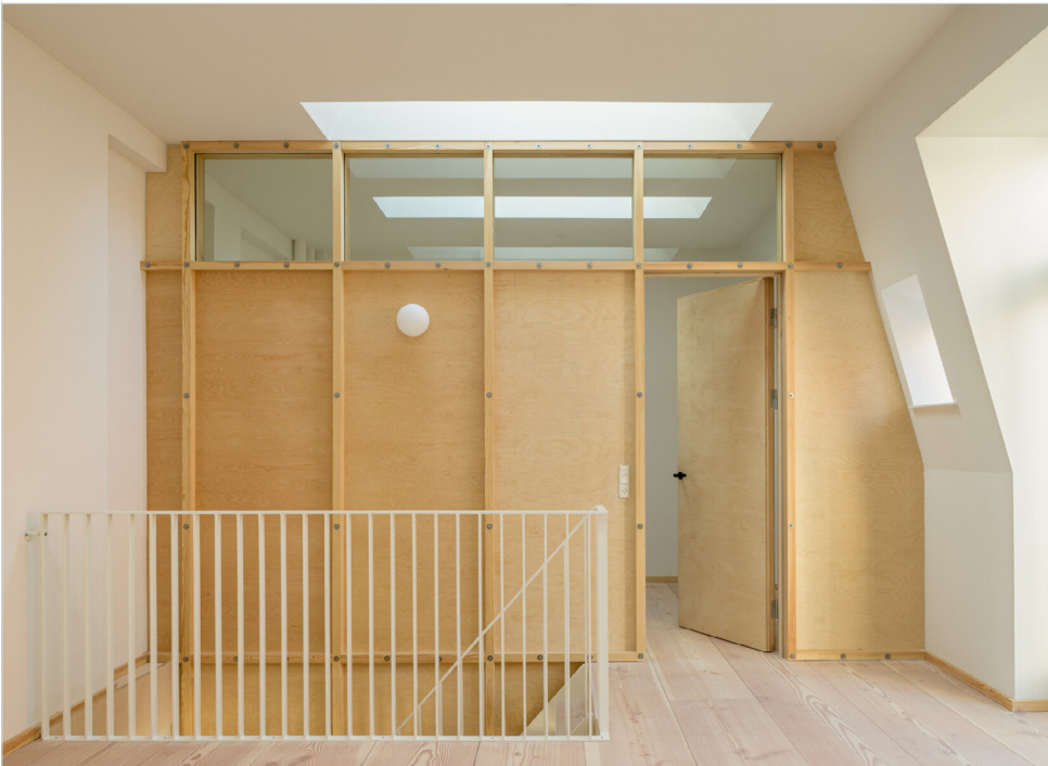
Sølvhuset / Panum & Kappel / 2022 / Foto: Hampus Berndtson. I denne ombygning har man etablere en ny indervæg i træ med transparente vinduer øverst, som skaber opdeling og lader lyset passere mellem rum.
