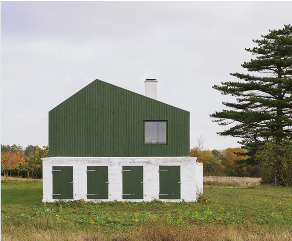
Det Danske Landsted / Norrøn / 2014 / Foto: Hampus Berndtson. En eksisterende landbrugsbygning er ombygget ved at bevare de tunge teglstensvægge og tilføje en let trækasse ovenpå – en løsning, der både skaber arkitektonisk spænding og reducerer CO 2 -aftrykket.
