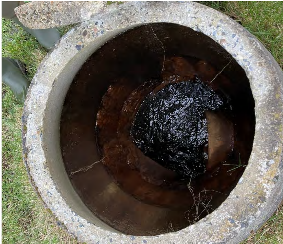
Figur 42 Brønd på matr.nr. 21n. Tilløb fra afvandingsystem 24-27 ses i højre side af foto
