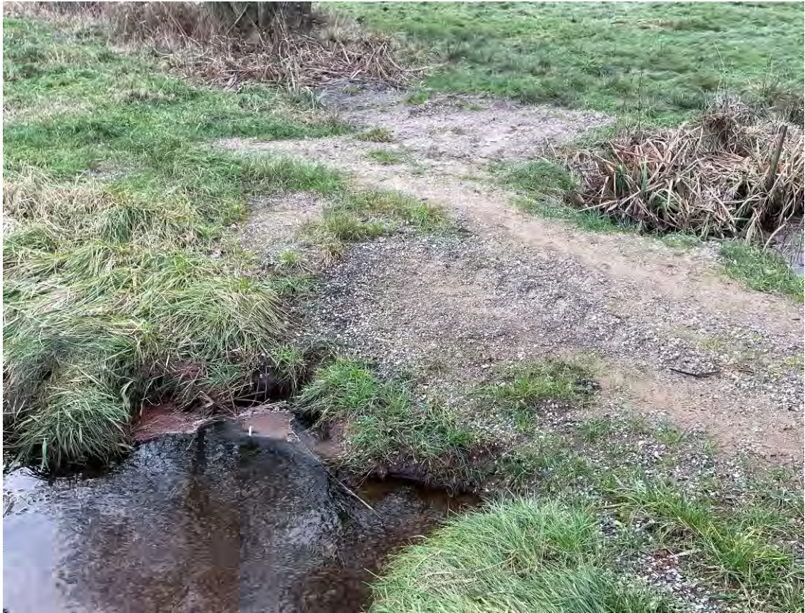
Figur 14 Foto af eksisterende rørbro 2.
