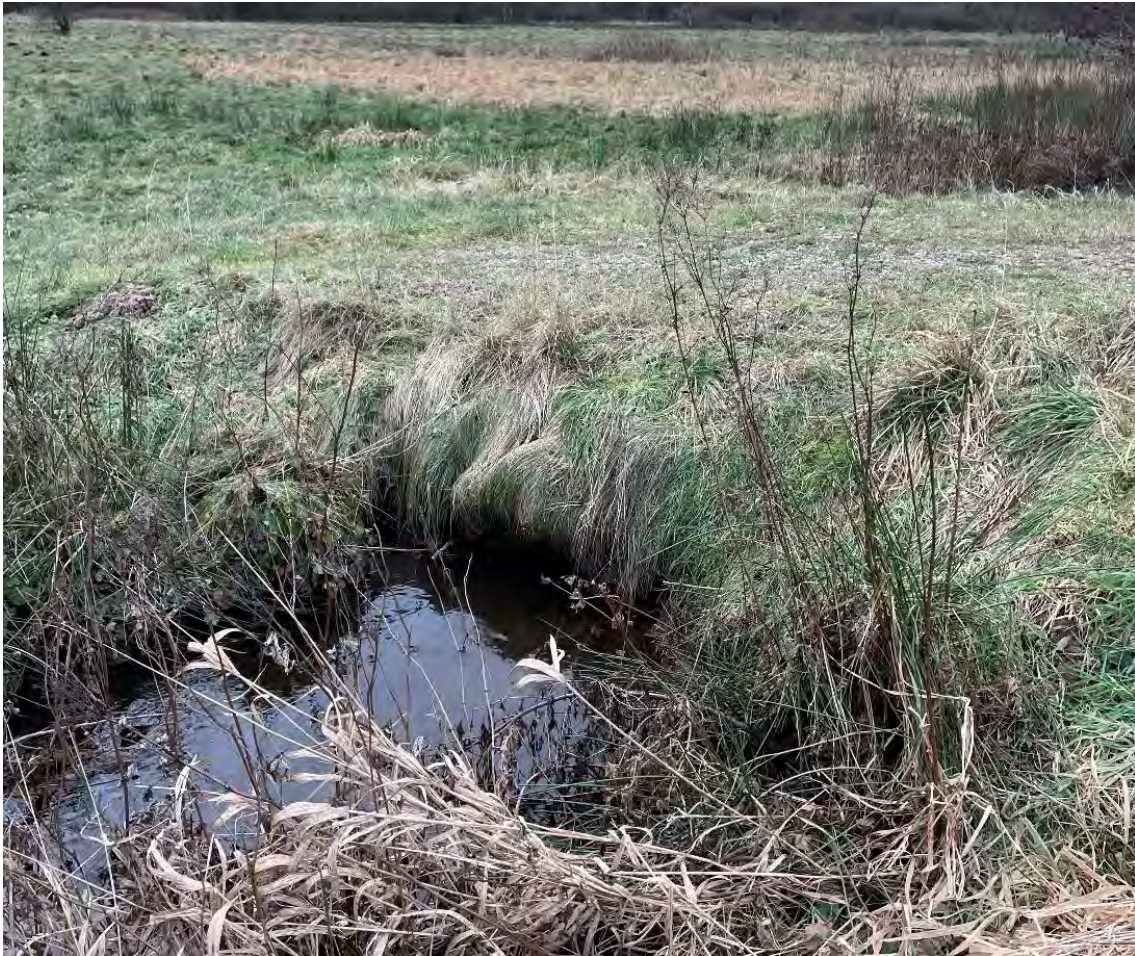
Figur 13 Eksisterende rørbro (bro 1) i eksisterende St. 2.087-2.093 m
