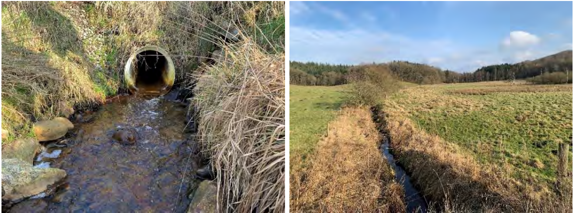
Figur 11 Eksisterende rørudløb ved Korreborgvej (tv) og arealet for genslyngning af Etape 1 (th)
