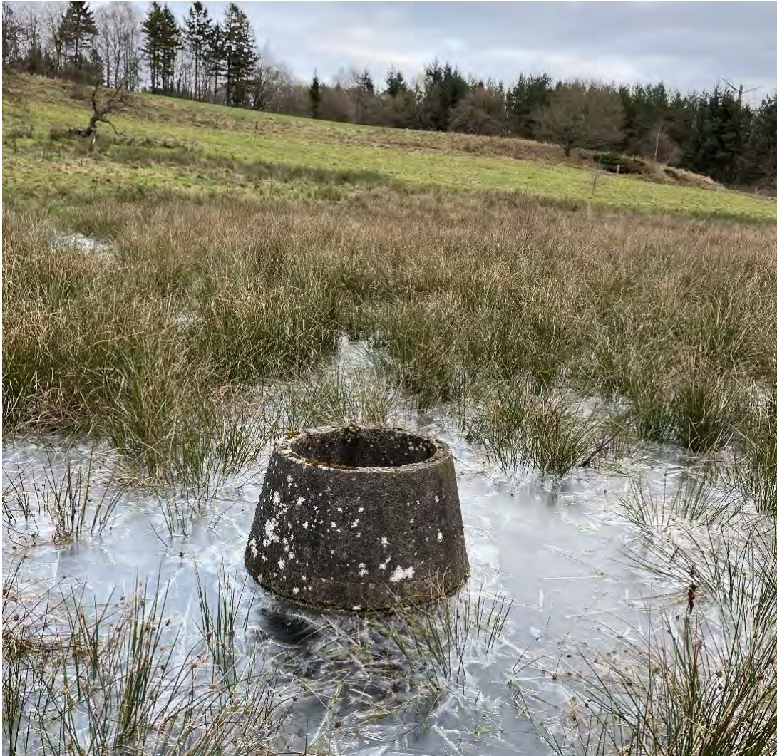
Figur 37 Brønd ved afvandingsystem 19
