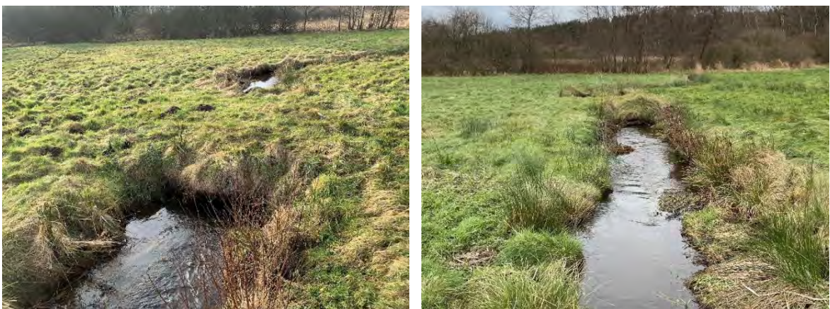
Figur 15 Eksisterende rørbro i St. 2.452-2.456 m
