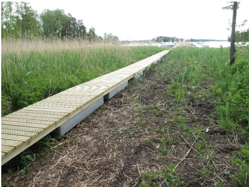
Referencefoto af pontonløsninger som ophalerplads og boardwalk fra andre steder i Danmark
