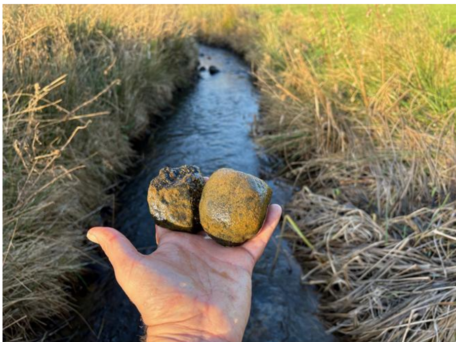
Figur 9 Eksempel på udlagte sten i Made Kilde ved etableringen af omløbet. Stenene er for store og ikke egnede til gydning for laksefisk.
