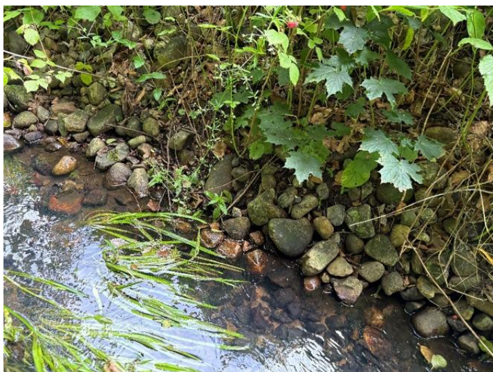
Figur 2 Ved etablering af omløbet, blev brinkerne kantsikret med større sten, men der blev ikke udlagt gydegrus.
