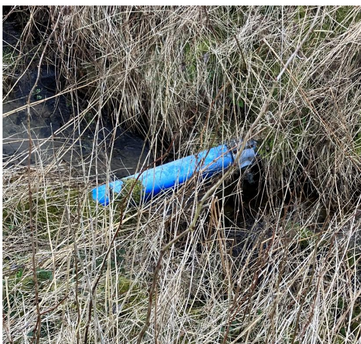
Figur 4-30: Ledning som krydser Løvskal Bæk i ca. st. 365 m.
