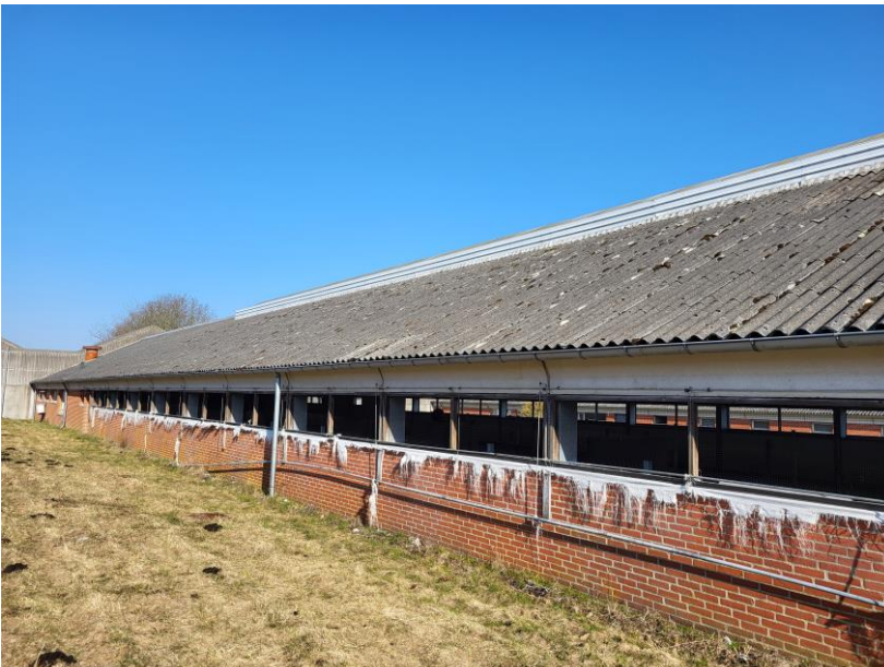
Figur 2-3 Bygning 3 set fra sydvest. Bygningen ligner udvendigt bygning 6.
