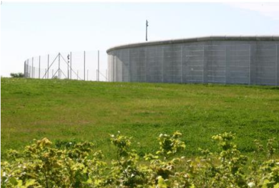
Figur 4-8 Eksempel på perimetersikring i beton set udefra.
