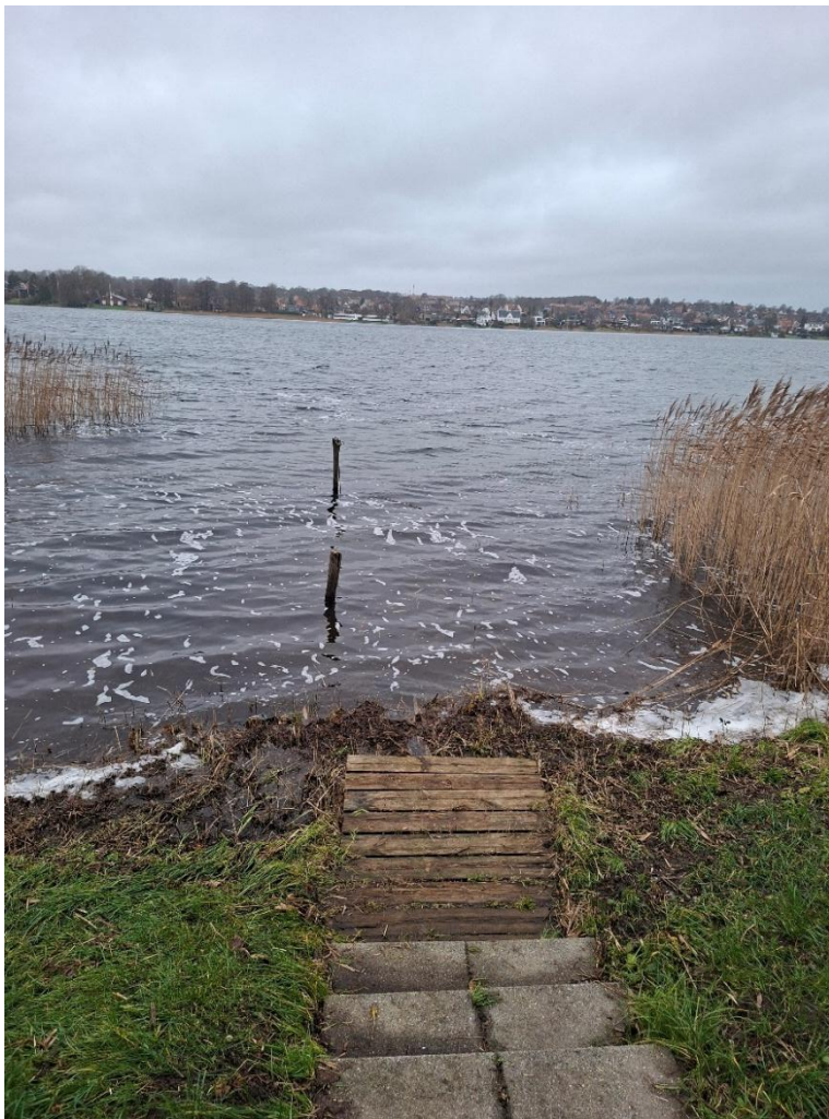
Trappe ned til det gamle broanlæg
