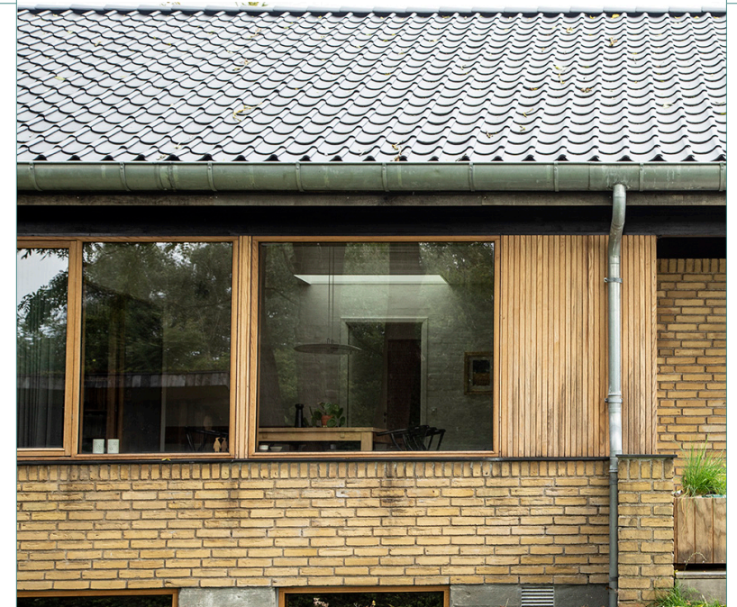
Renovering af villa / Tegnestuen Lorenzen / 2018. Foto: Tegnestuen Lorenzen.
