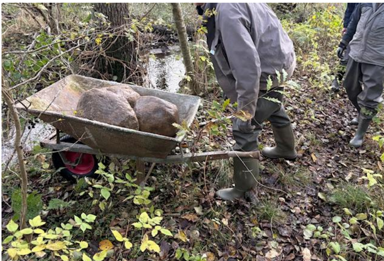
Figur 14 Udlægning af skjulesten foregår skånsomt og ved brug af trillebør til transport af stenene.
