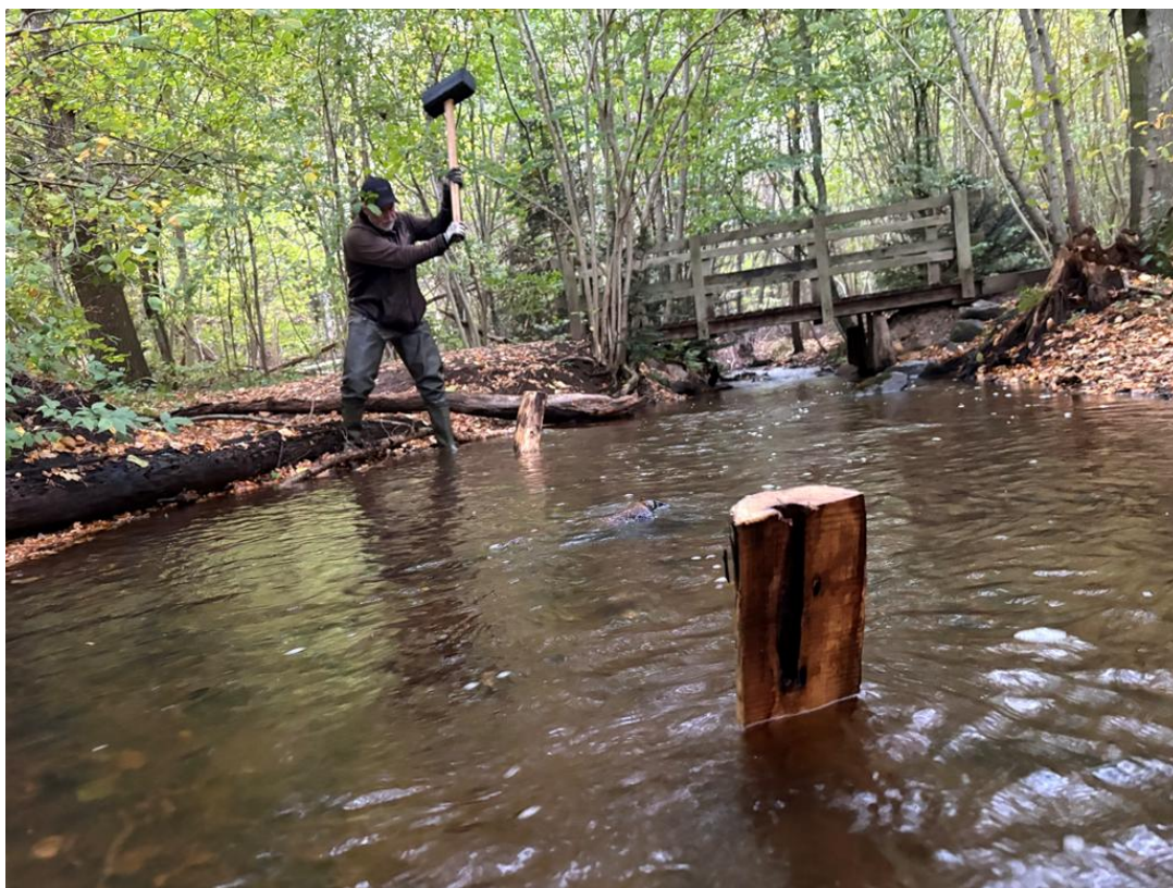
Figur 4 Isætning af pæle i vandløbsbunden foregår manuelt. Pælene stikker ca. 40 cm op over vandspejl og bidrager til at opsamle dødt ved og skabe skjul.
