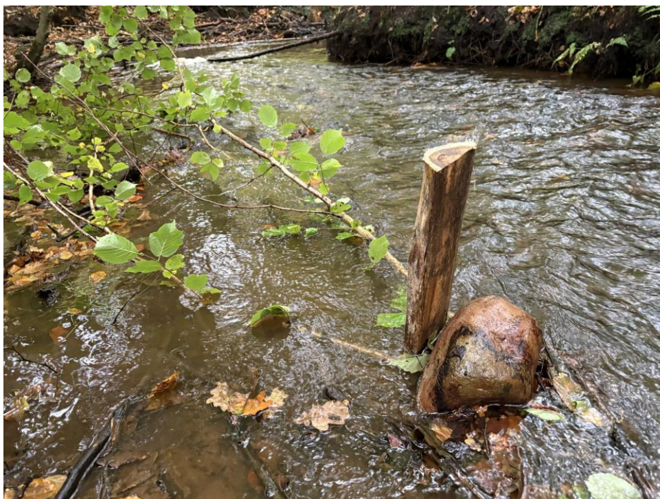
Figur 7 For at undgå at dødt ved drifter nedstrøms og danner stuvningssoner, fikseres dødt ved ved de isatte pæle. Der benyttes V-grene til at skabe skjul.
