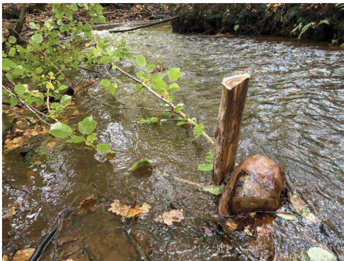
Figur 5 Et eksempel på etablering af skjul til ørredyngel ved udlægning af grenmateriale og isætning af stolper.
