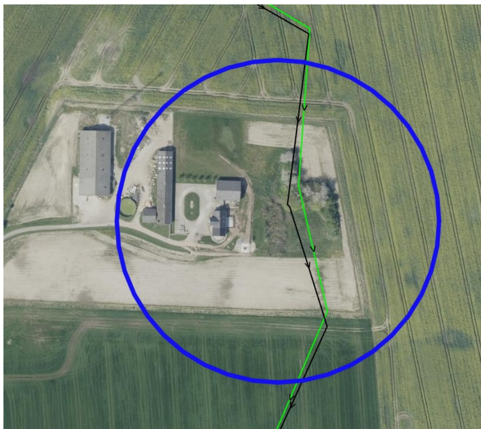
Figur 2. Åbning af rørledning der er markeret med sort streg. Grøn ledning er eksisterende spildevandsledning ejet af Energi Viborg Vand
