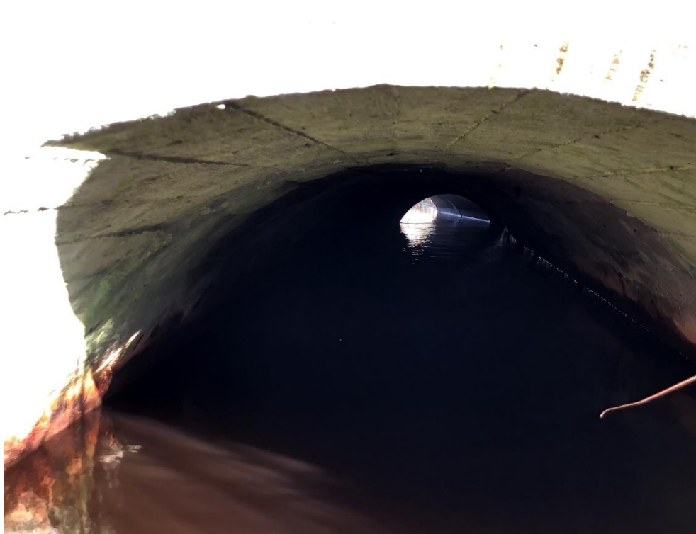
Figur 7: Krydsning af Korreborg Bæk ved Bromøllevej. Underføringen fremstår med et tydeligt knæk og ændret rørdimension.
