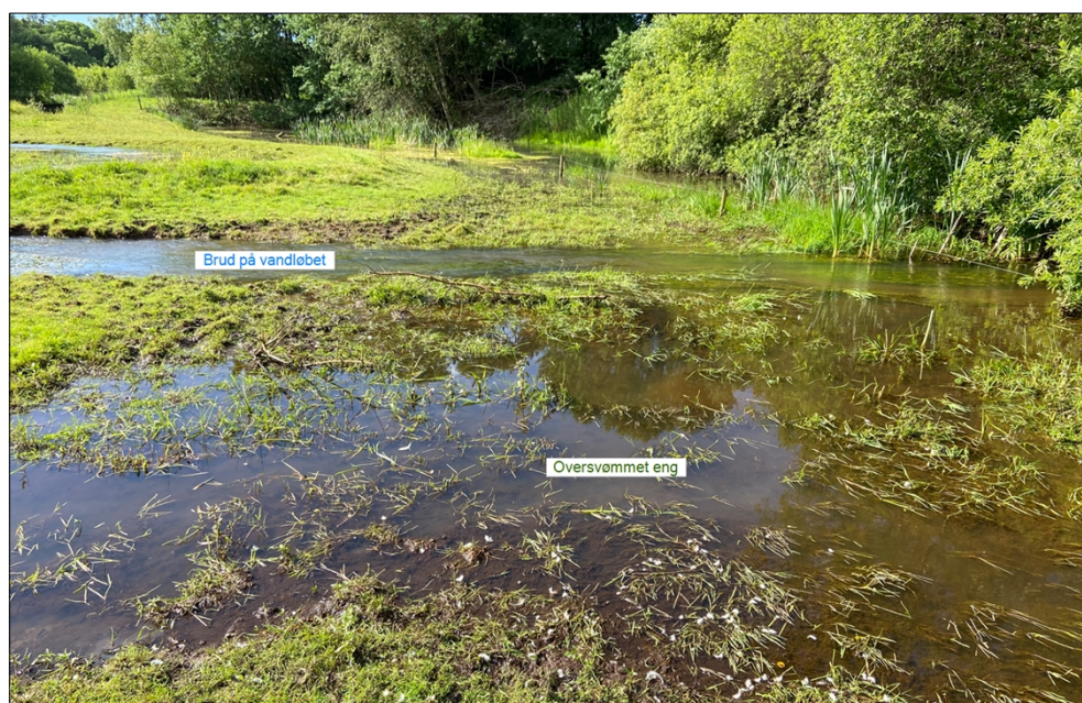
Foto af brud på vandløbet, hvoraf det ses, at der er dannet et nyt "vandløb", hvor vandet løber over i bagkanalen. Dertil er der oversvømmet på engen mellem det genslyngede vandløb og bagkanalen. På det oversvømmede areal ses, at der er mudret på grund af aflejret materiale og at dyrene har trådt det op.
