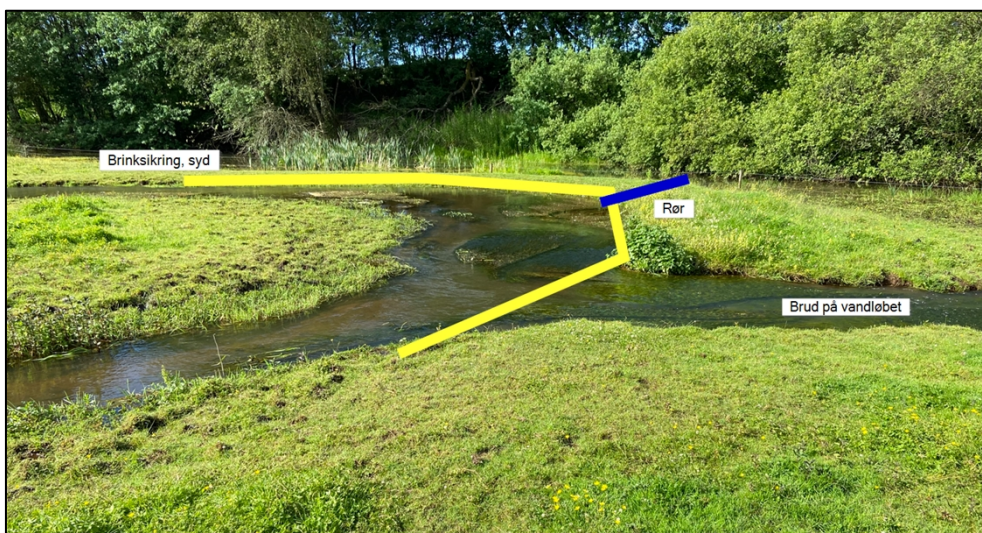
Foto af svinget længst mod syd inden for projektområdet. Der skal laves brinksikring i ydersvinget, som er angivet med gul streg, og der skal anlægges et rør omtrentlig ved den placering angivet med blå streg.
