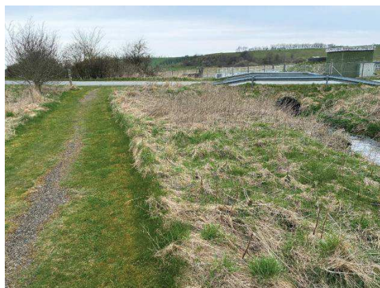
Figur 8 Den eksisterende sti langs projektområdet er kørefast og egnet til at tilkøre grus og sten til bækken. Fra stil til vandløb benyttes køreplade i plast.
