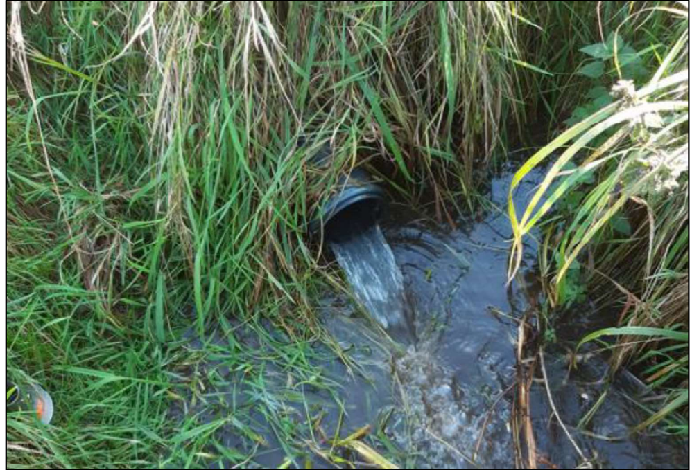
Figur 11: Rørdløb under markoverkørsel i tilløbet til Dybdal Bæk.
