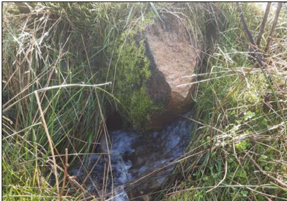
Figur 30: Udløb i Vigstrup Vandløb.
