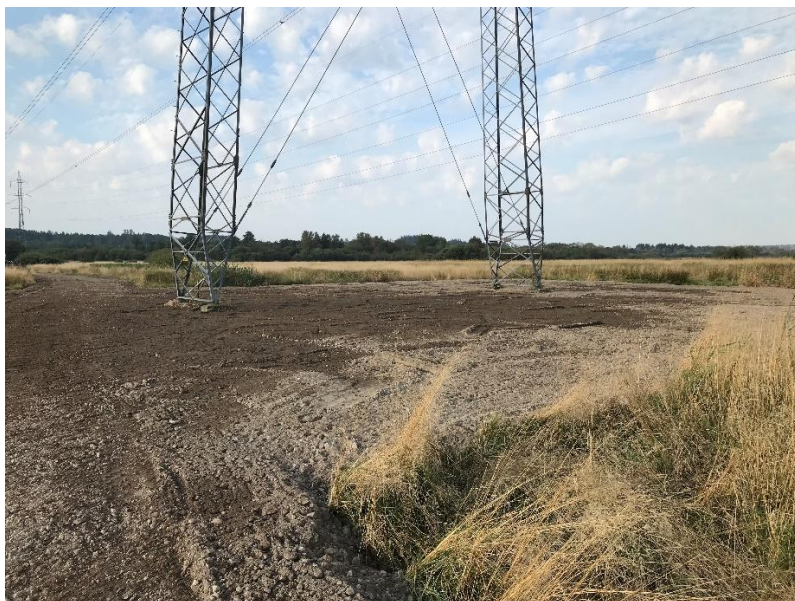
Anlægsarbejde under højspændingsmaster, august 2024
