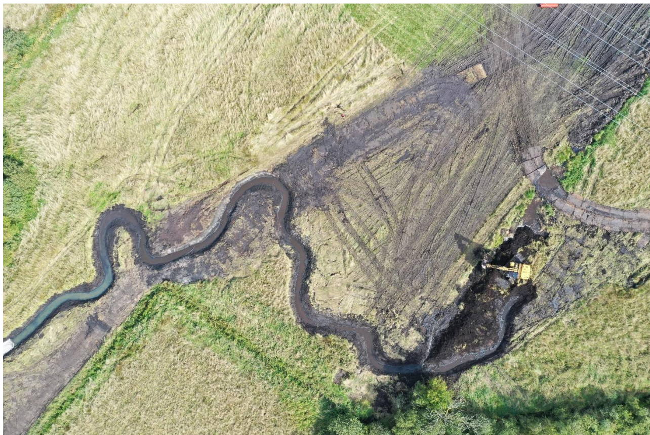
Dronefoto fra udgravning af nyt forløb af Vammen Afløbsgrøft, set fra syd. Foto: HedeDanmark
