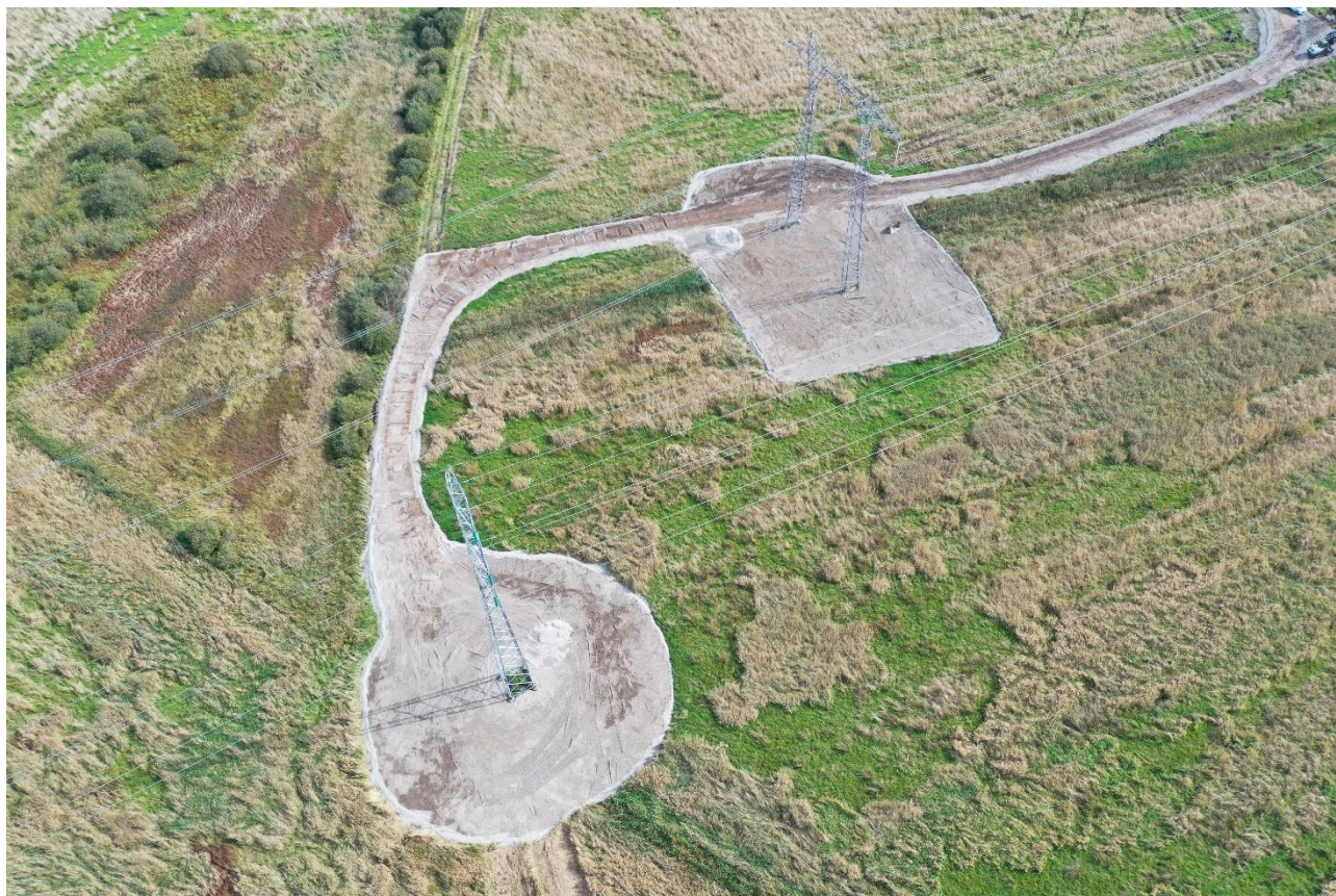
Dronefoto af adgangsvej og platforme, set fra vest.
