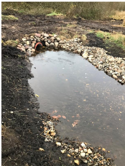
Overkørsel og nyt forløb af Vammen Afløbsgrøft.
