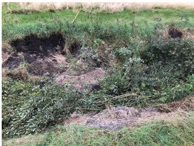
Sløjfning af grøft med nedlægning af buske og jord fra balker
