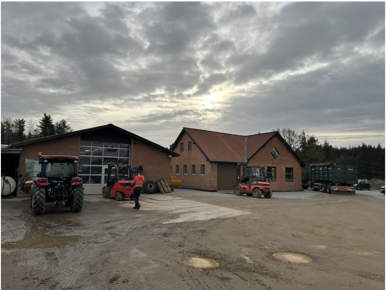
Eksisterende bebyggelse der rives ned
