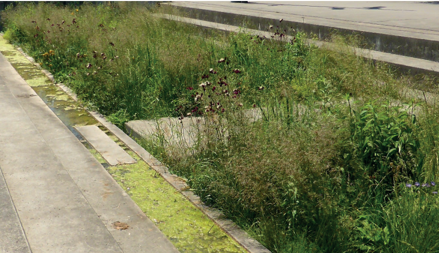
EKSEMPEL TIL INSPIRATION - - Regnvandsbede opsamler og forsinker overskydende vejvand på hærvejen
