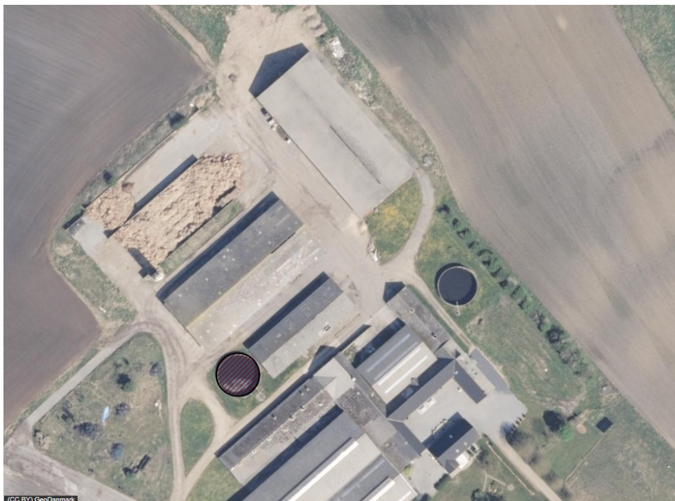
Figur 2 Markering af tank til opbevaring af spildevand
