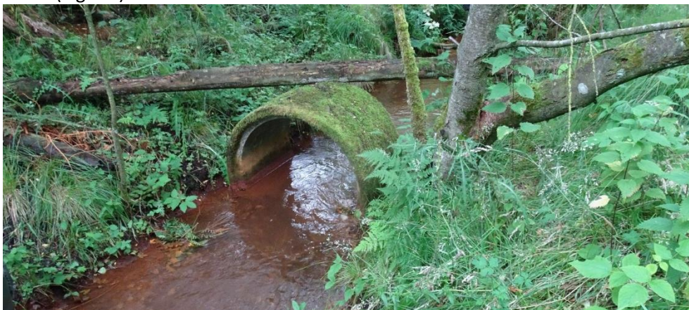
Figur 6. Betonrør ved st. 7.988.
