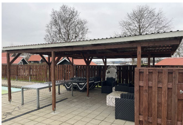
Figur 3 - Foto af overdækning ved bassin
