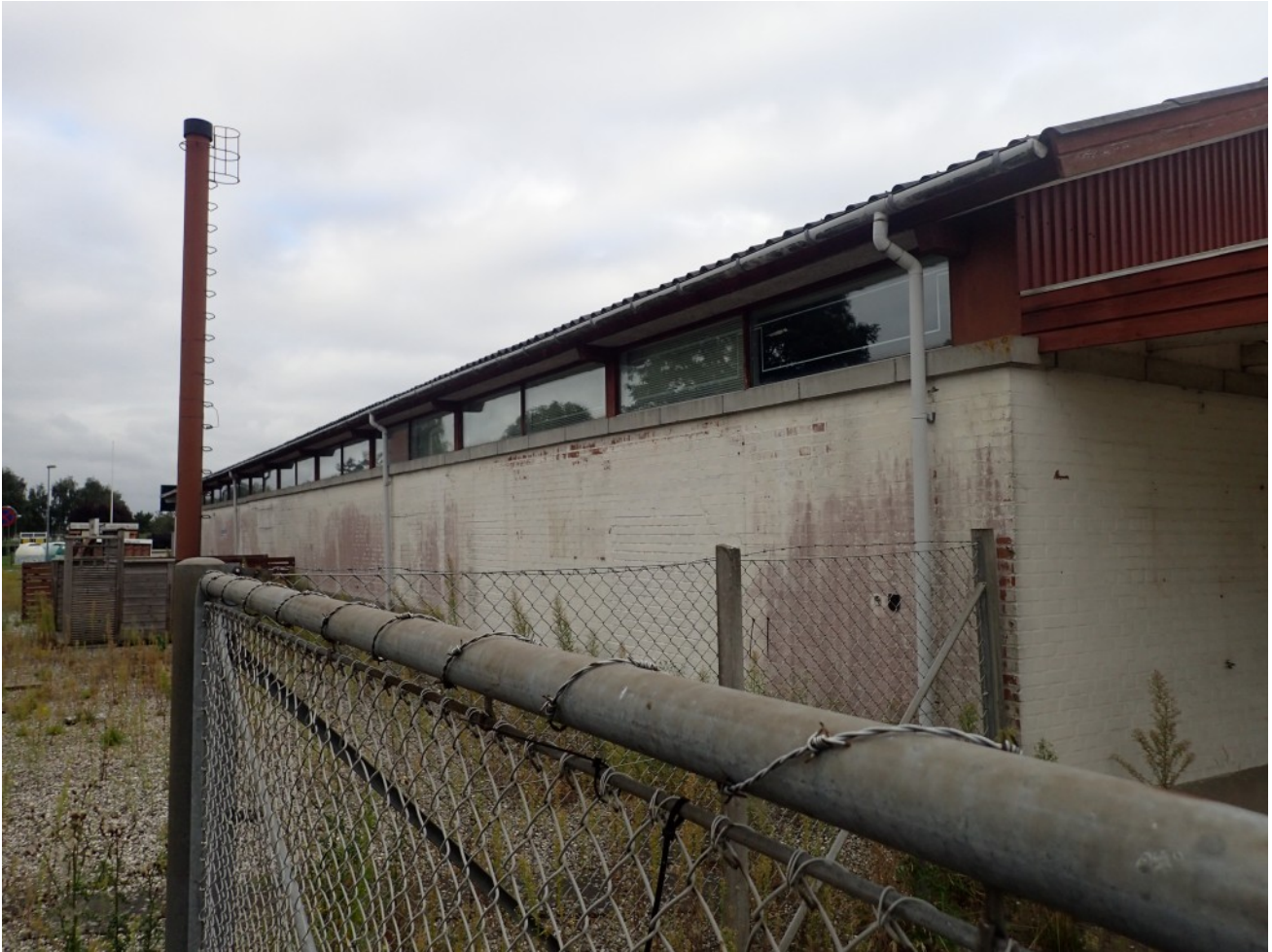
Foto 3: Eksisterende hegn der omkranser hele området. Foto taget fra Solvænget i nærheden af indkørsel i syd.
