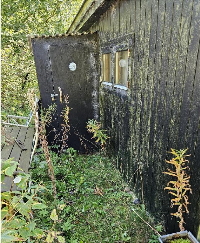
Foto 3 Udvendig koste- og værktøjsskab.
