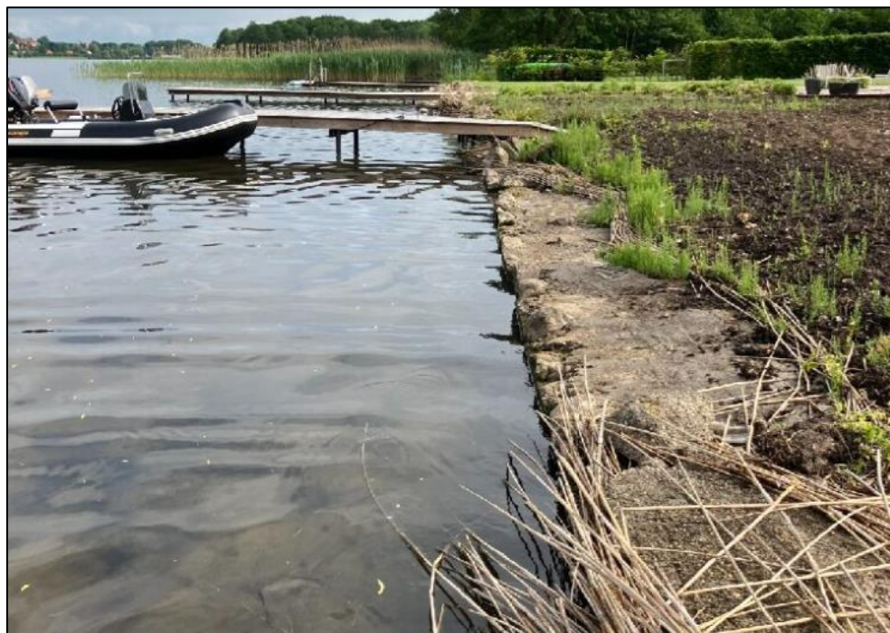
Foto fra kommunens besigtigelse i forbindelse med anden sagsbehandling den 24. maj 2024, hvor bolværk langs ejendommen kan ses.
