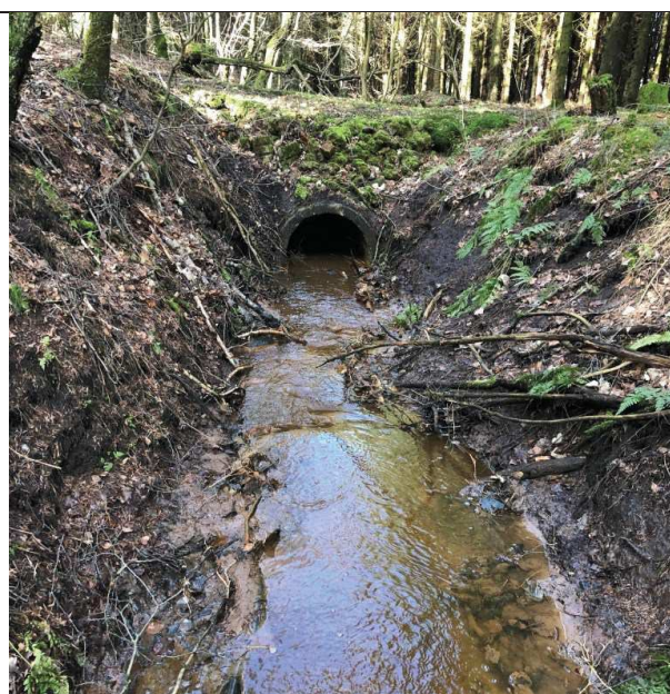
Afløb Hjorthede, delstrækning umiddelbart nord for projektområdet med Ø 80 cm rørbro
