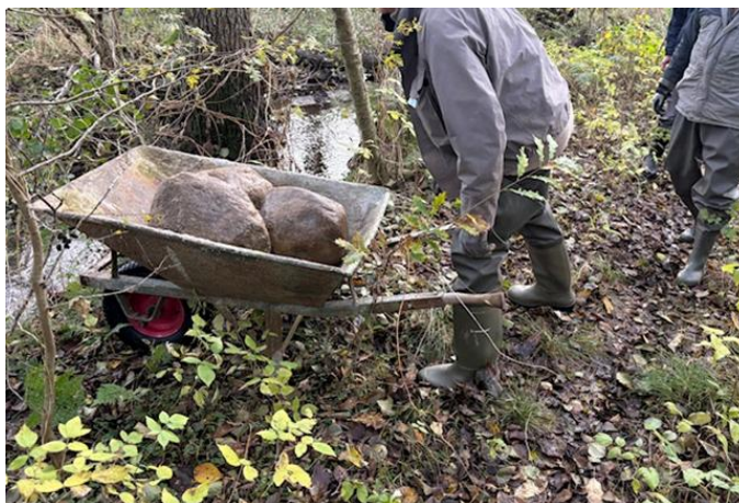
Figur 14 Udlægning af skjulesten fra depot til vandløb sker skånsomt og med trillebør.
