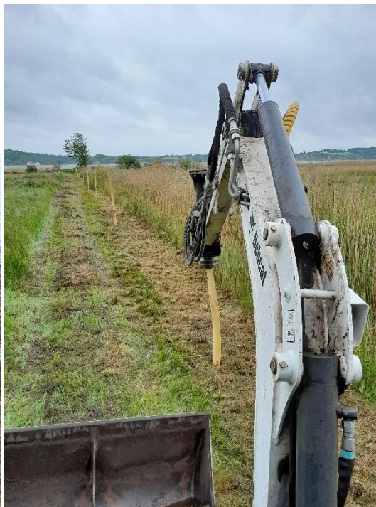
Eksempel på nedramning af pæle med minigraver
