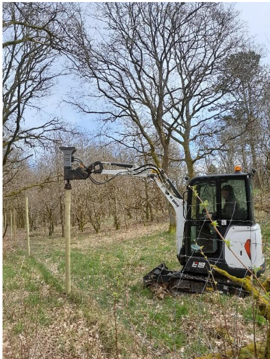
Eksempel på nedramning af pæle med minigraver
