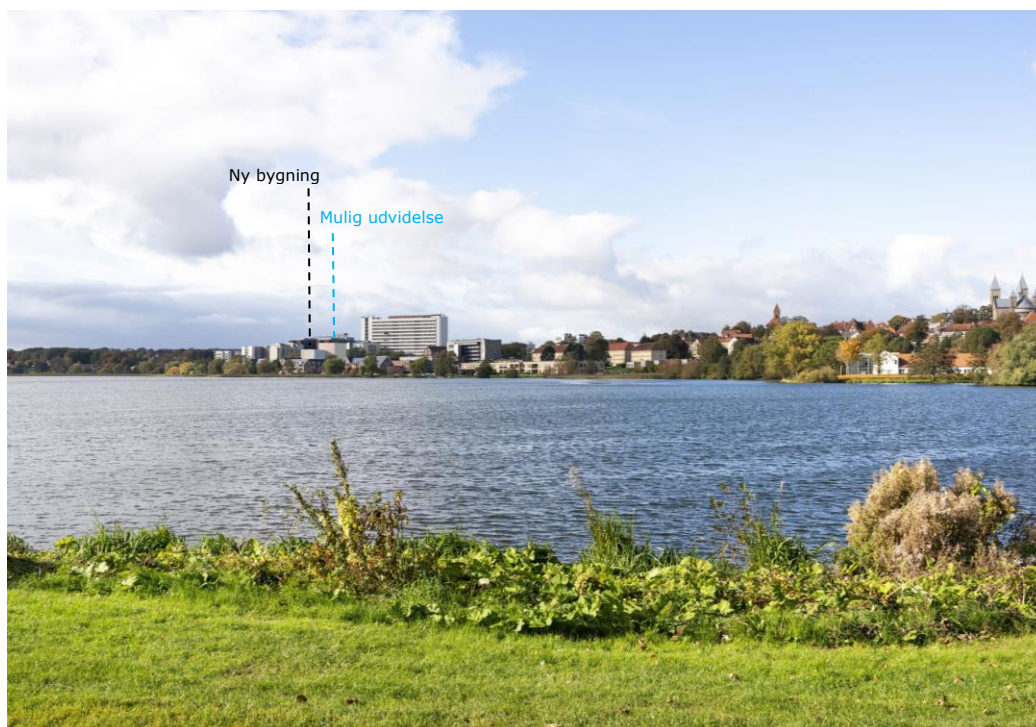
Figur 7-10: Visualiseret fremtid set fra Kloster Allé og viser både den nye bebyggelse (sort linje) og en mulig udbygning (blå linje).
