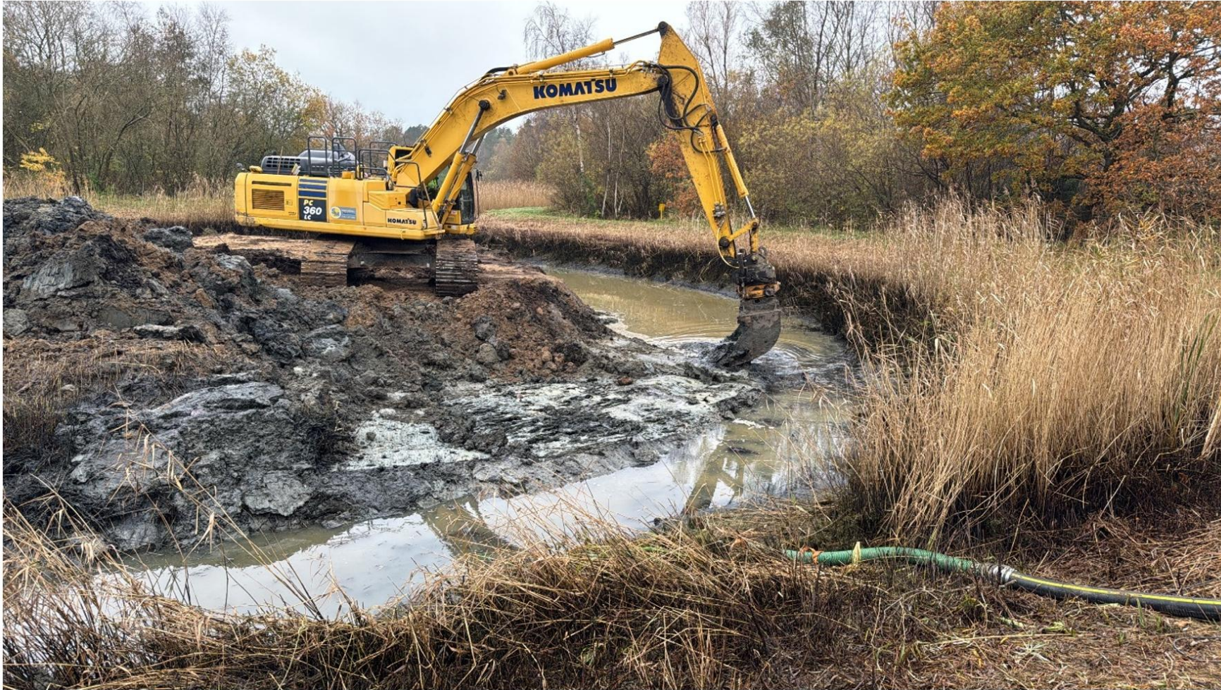
Fjernelse af ø i regnvandsbassin ved Egerisvej for at skabe mere volumen
