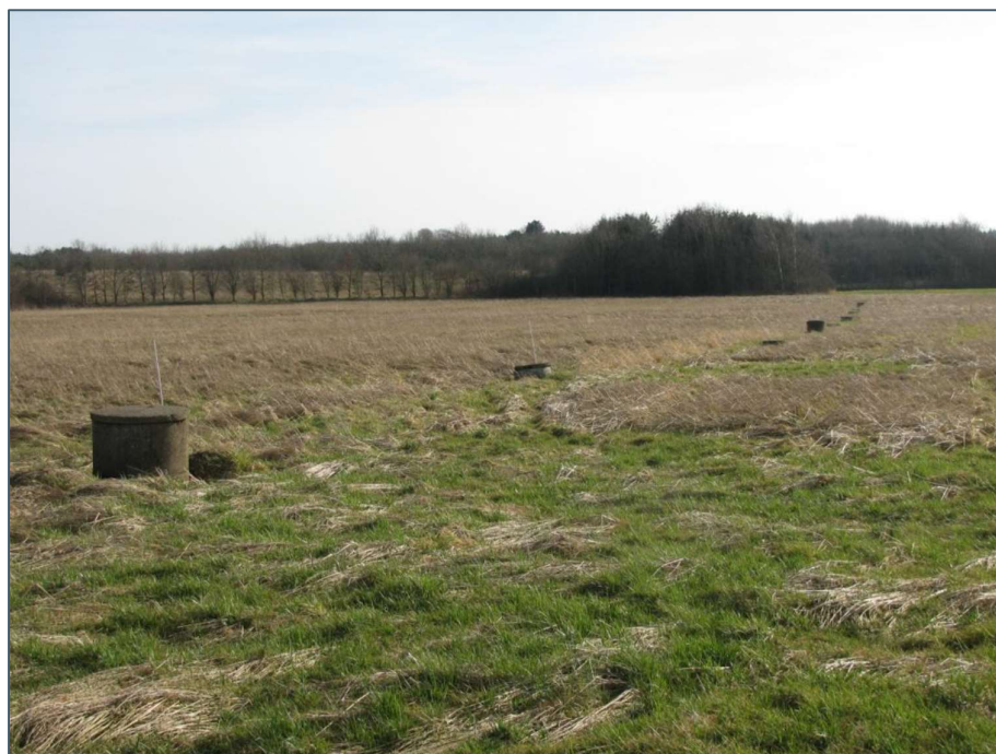
Figur 3-5. Billede af drænbrønde i området.
