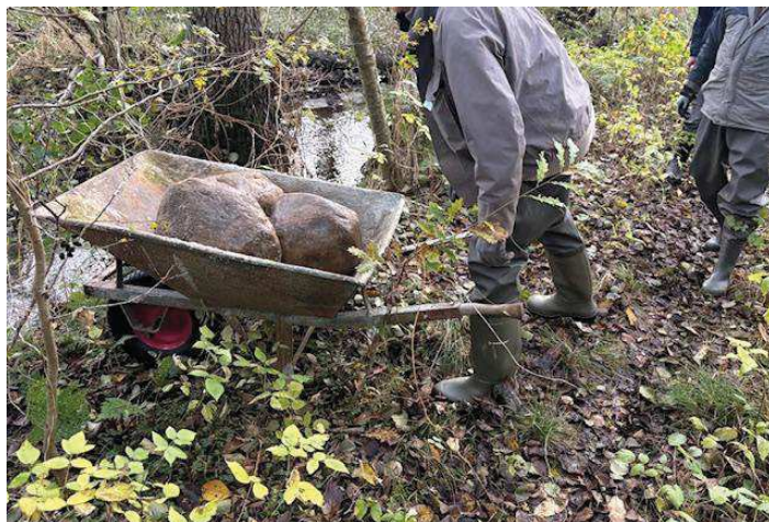
Figur 13 Langs den nederste del af projektstrækningen, hvor denne løber gennem, dog ganske tørt, §3 moseområde, vil der blive benyttet almindelig trillebør til udbringelse af skjulesten.
